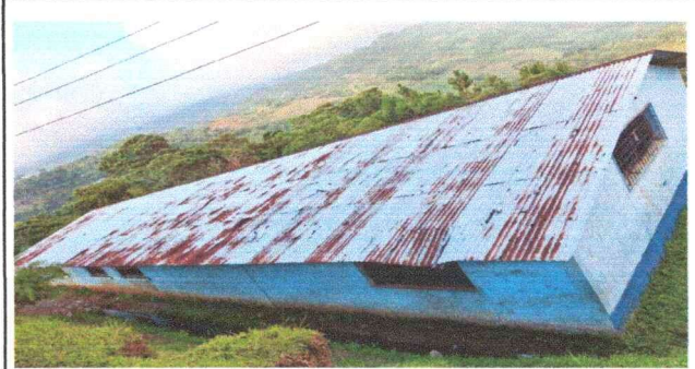
Foto 2: Sustitución de láminas acanaladas a láminas troqueladas, y mantenimiento de balcones y pintura exterior y interior.
