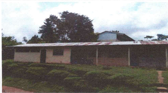
Foto1: Sustitución de láminas acanaladas a láminas troqueladas, y mantenimiento de estructura de portante de metal.
