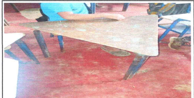
Foto 6: Sustitución de piso de torta de cemento a piso ceramico en el modulo 2 de 4 ambientes.
