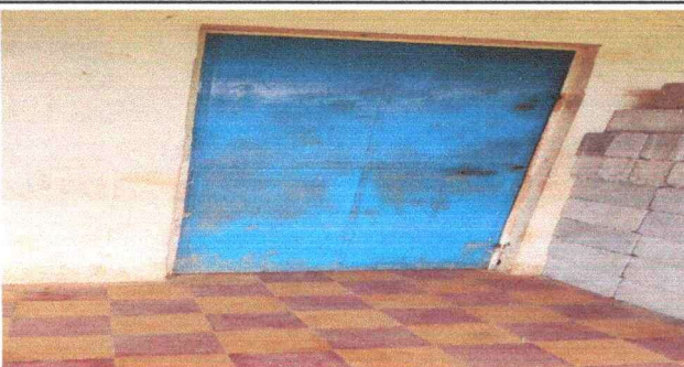
Foto 5: Mantenimiento puertas de metal en el modulo 1 de los 3 aulas y bodega.
